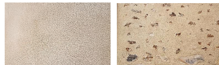
Mur enduit et mur jointoyé à pierre vue ©UDAP 77
