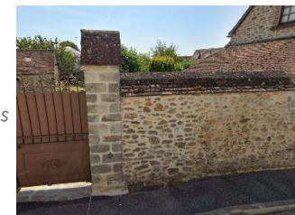
Mur en moellons ©2023 Google
