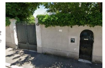
Mur enduit ©2023 Google
