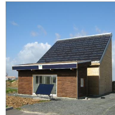
implantation sur une toiture mono-pente
